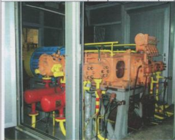
Фото 3: Компрессор с электродвигателем
