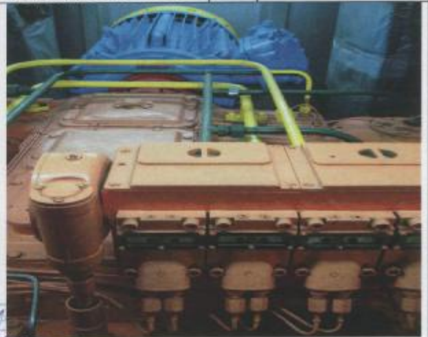
Фото 4: Компрессор с электродвигателем
